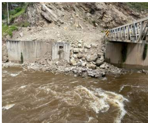
IMAGEN 01: SE MUESTRA EL COLAPSO DEL MURO DE CONTENCION, REQUIRIENDO DE DEMOLICION Y CONSTRUCCION DE MURO DE COCNETO PARA PROTECCION DEL PUENTE MODULAR ATALLA EN EL RIO ICHU
